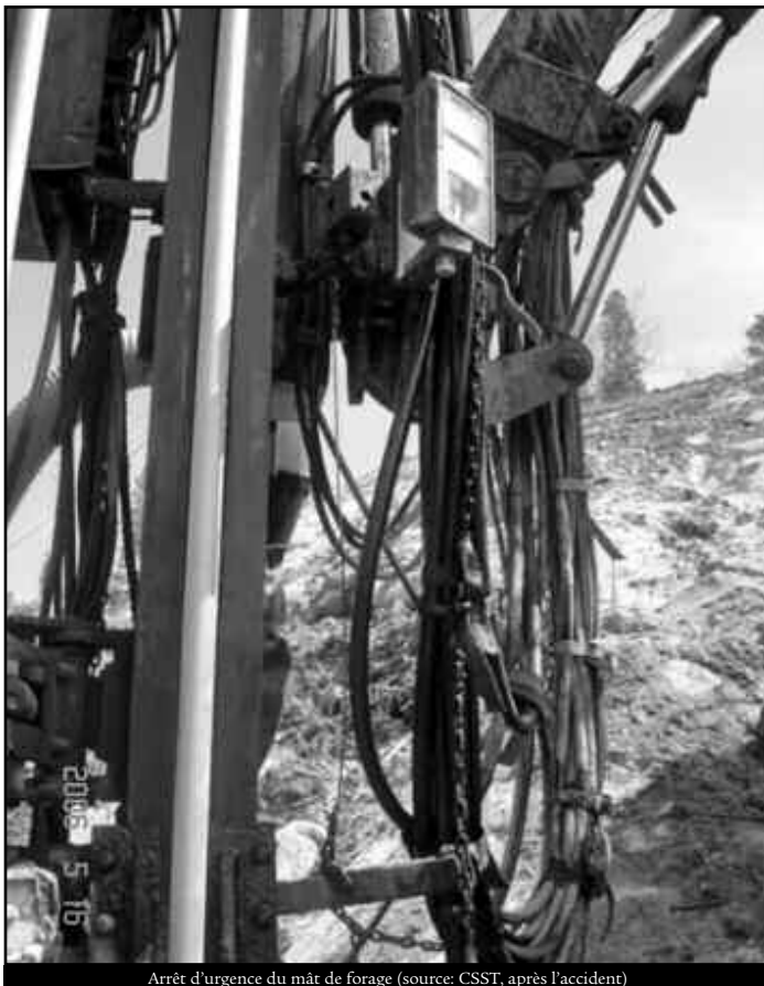
Arrêt d'urgence du mât de forage (source: CSST, après l'accident)
