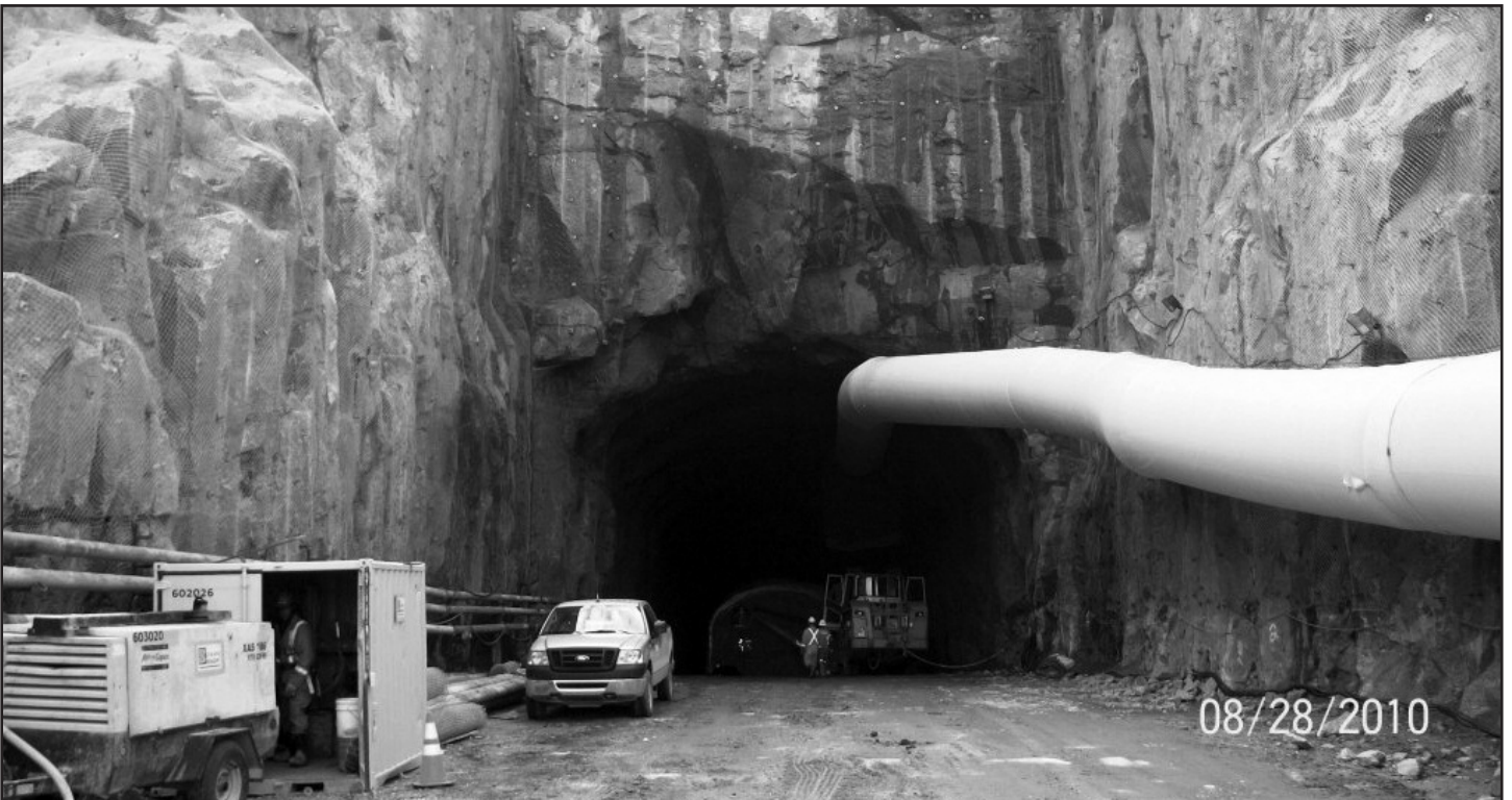
Tunnel chantier Simard et Beaudry
