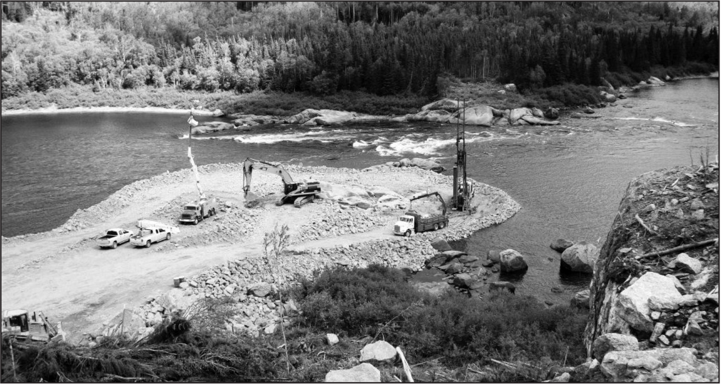
Chantier Neilson EBC construction d'un pont
