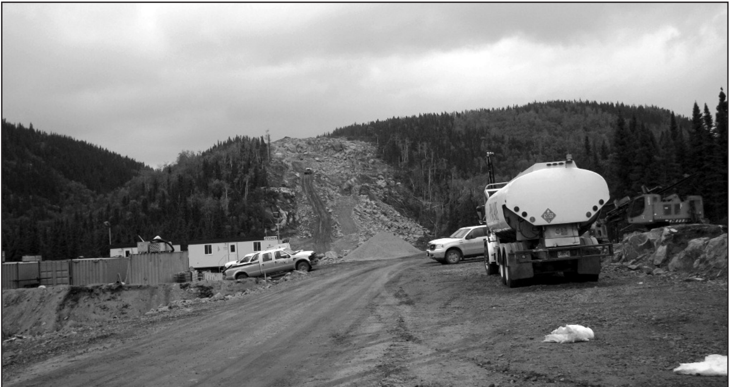
Coupe de roc, chantier Polaris
