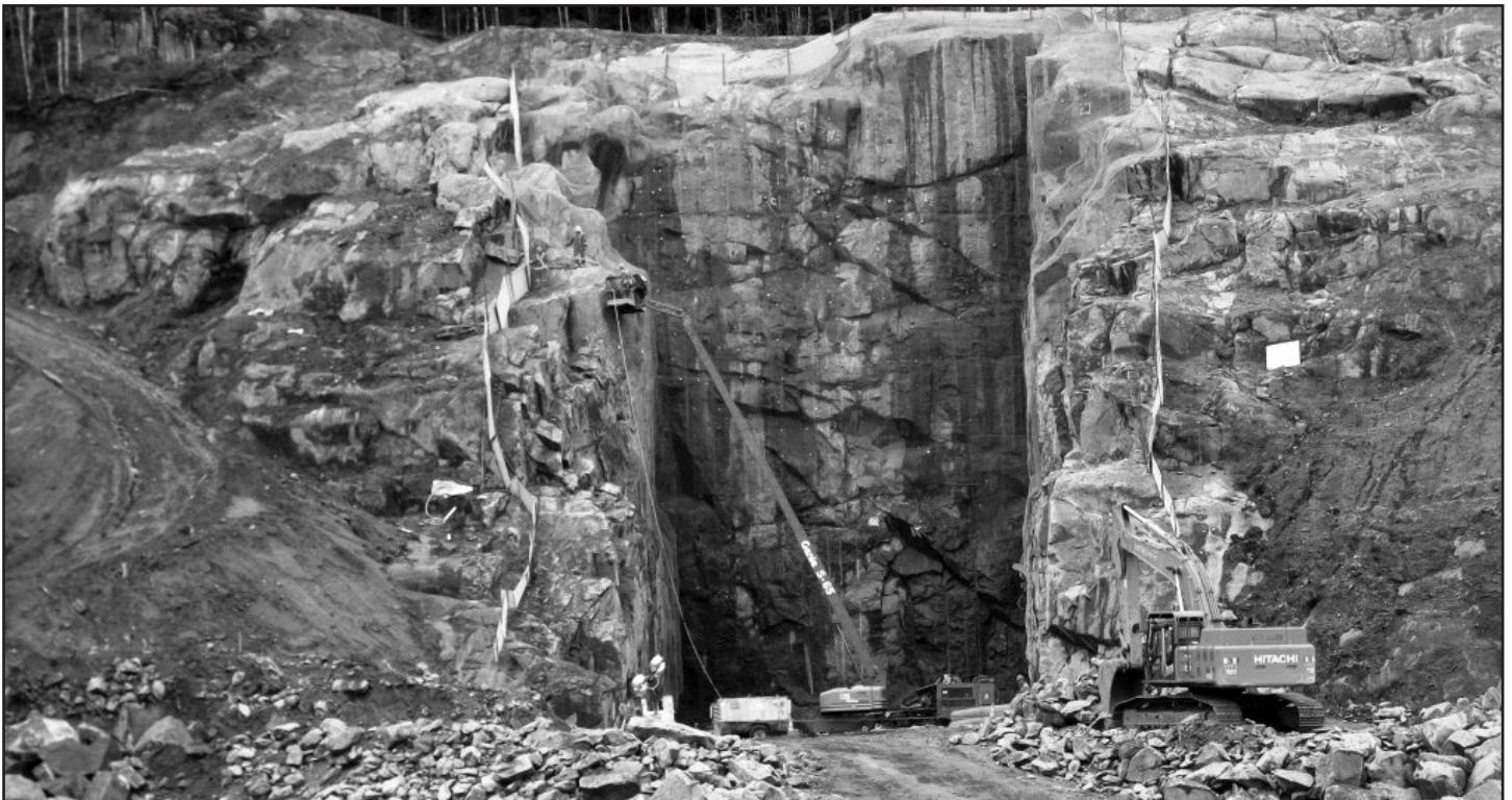
Portail chantier Simard et Beaudry
